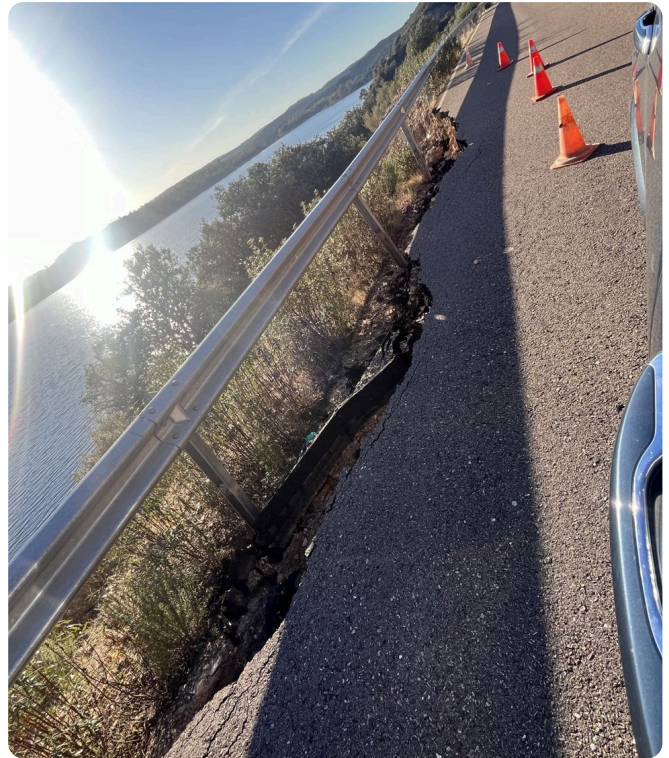
Octubre 2026. La rotura recorre la barrera, con el embalse justo debajo.
